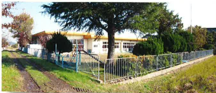
同保育園外柵（南西側）・写真番号：⑦
