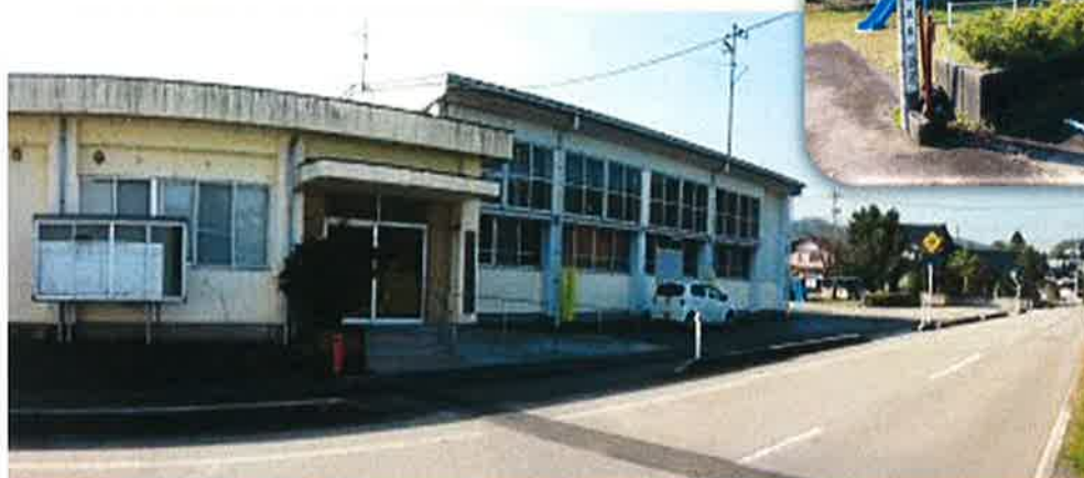
南砺市石黒公民館（北側玄関）写真番号：①
