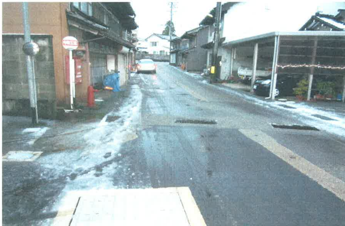
国道471号線:瑞泉寺方面 側溝合流部
