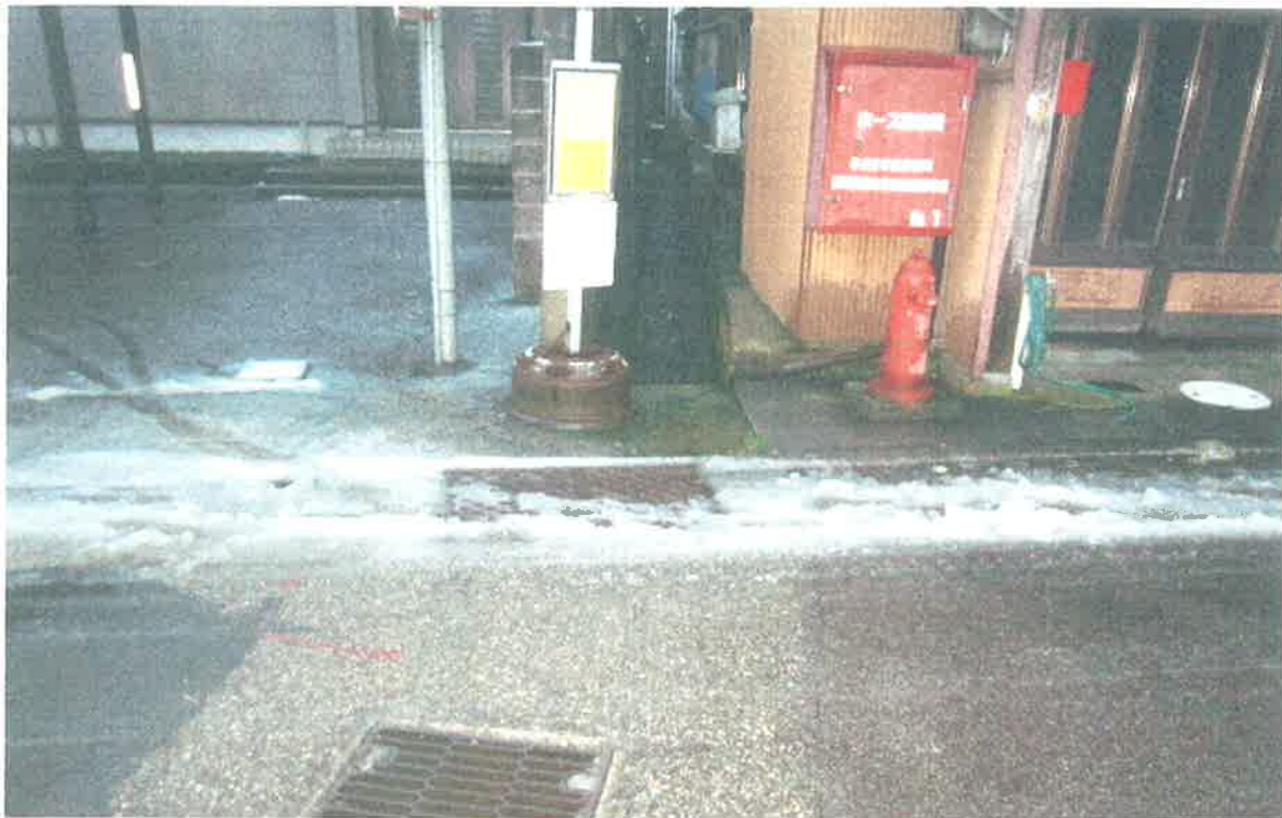
国道471号線側溝流入 既存側溝
