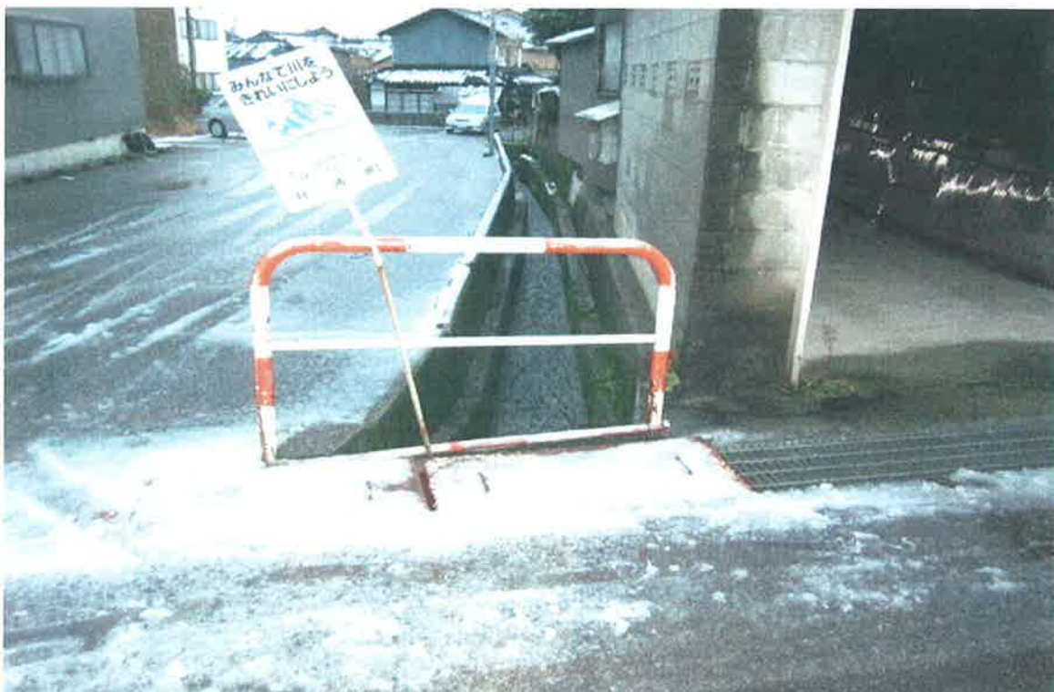
国道471号線道路横断暗渠下流 既存受入水路
