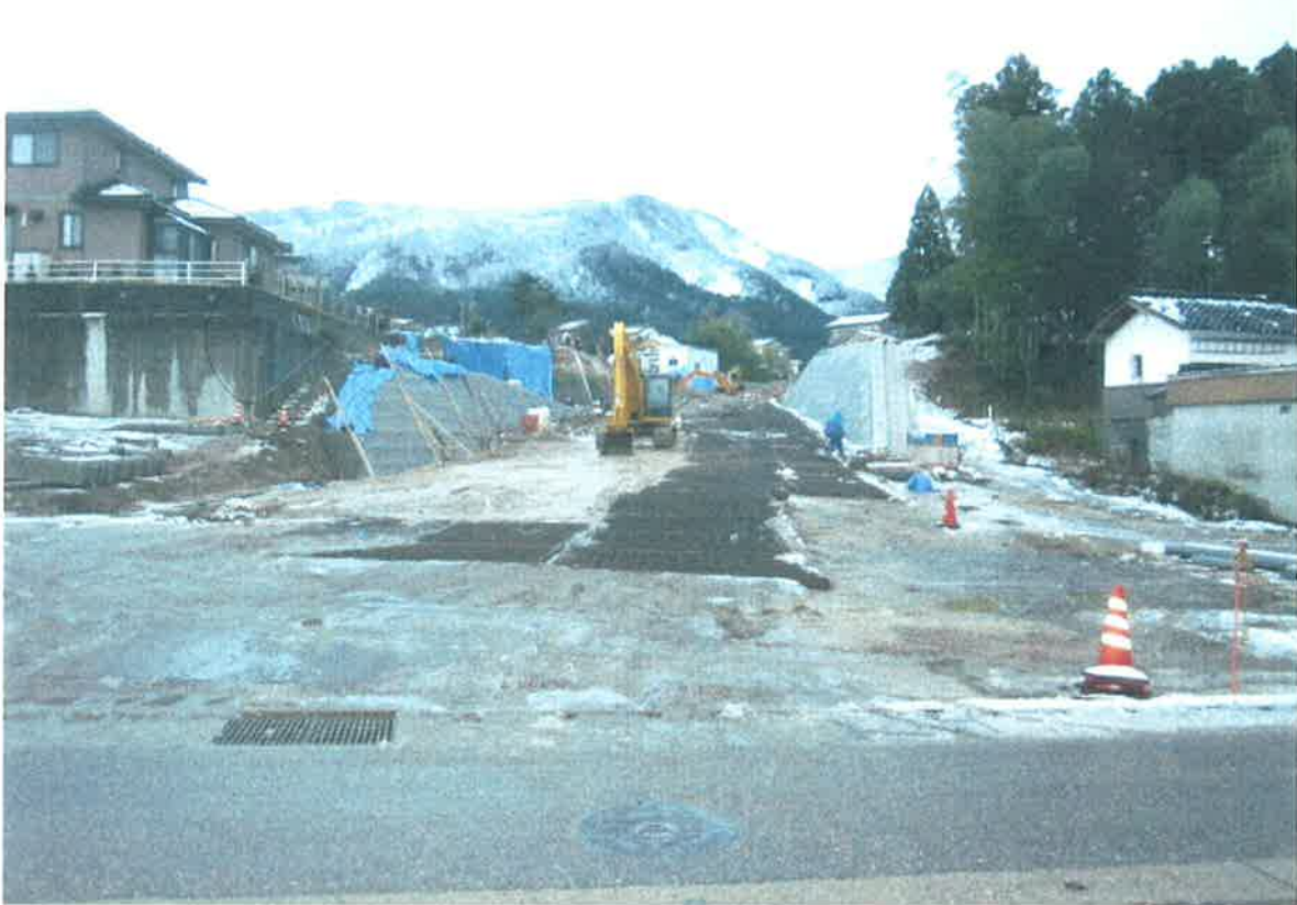
建設中 都市計画道路谷今町線（国道471号線より臨む）
