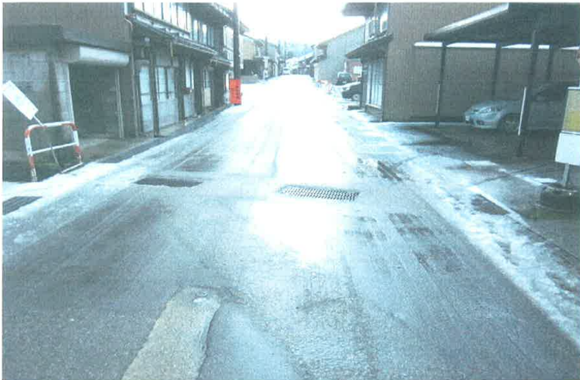
国道471号線道路横断暗渠
