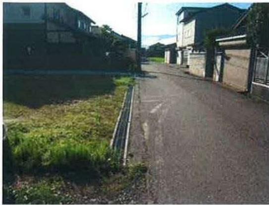
300m 地点ここもアスファルトの老朽化 流雪溝が無い 田んぼに投入
