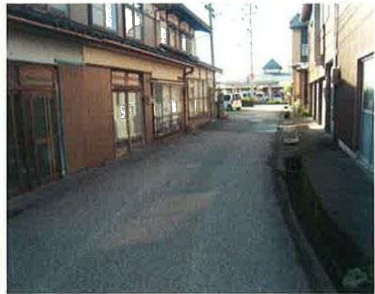
300m 地点ここもアスファルトの老朽化 流雪溝が無い 田んぼに投入
