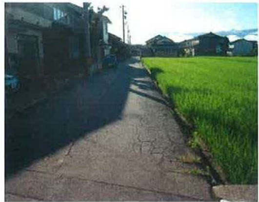
300m 地点ここもアスファルトの老朽化 流雪溝が無い 田んぼに投入
