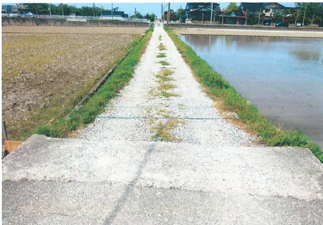
図2 市道 角田2号線 写真 2014/05/06 現在
