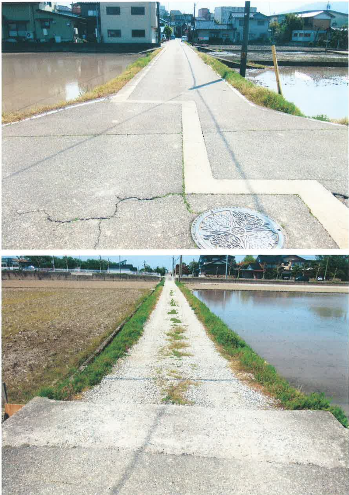
図 2 市道 角田 2 号線 写真 2014/05/06 現在
