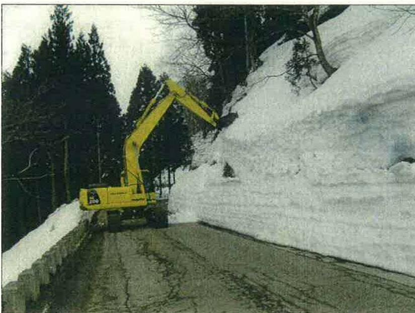
写真タイトル：バックホウによる除雪状況
