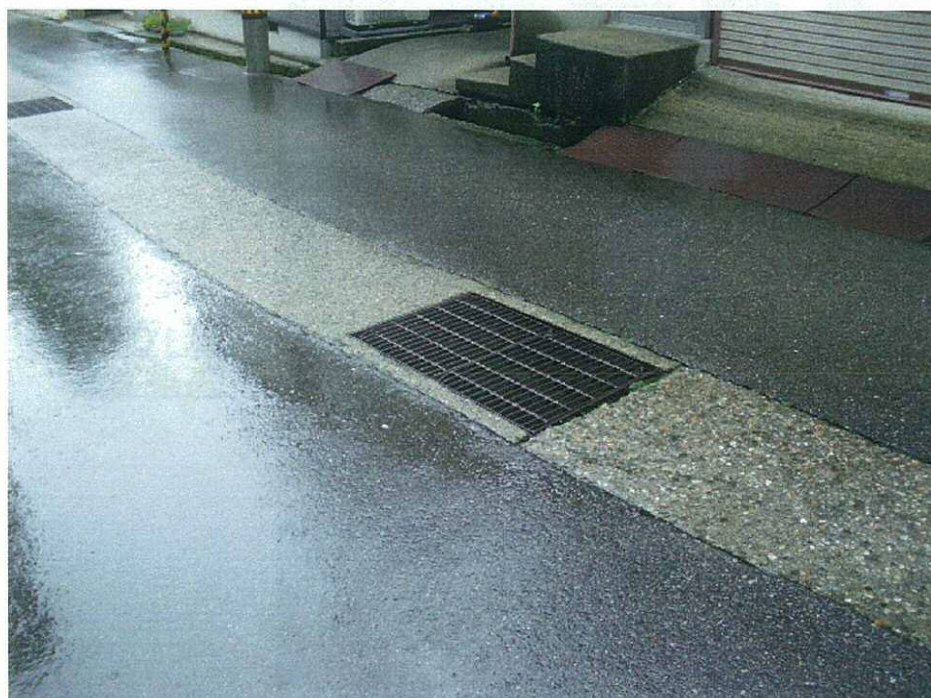
No. 4地点 水上宅車庫
