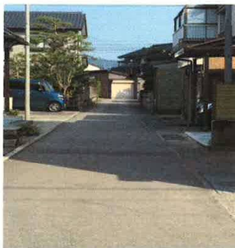
⑨天神町4号線 雨水溝で、流雪出来ない。
