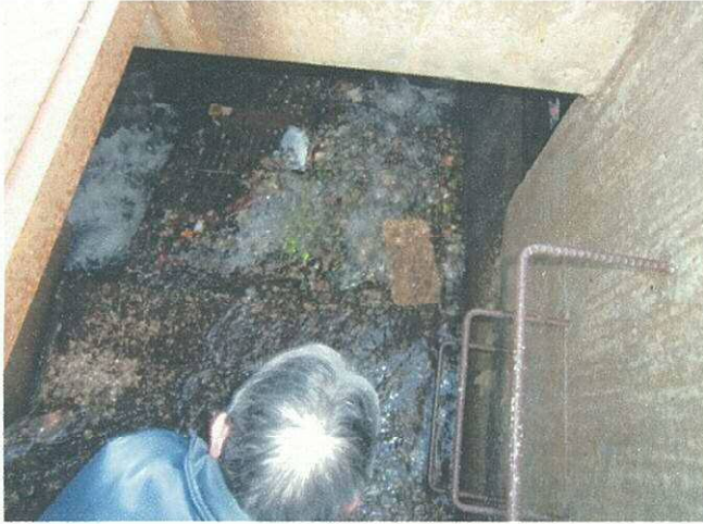
取水口 ごみが溜まった状態
