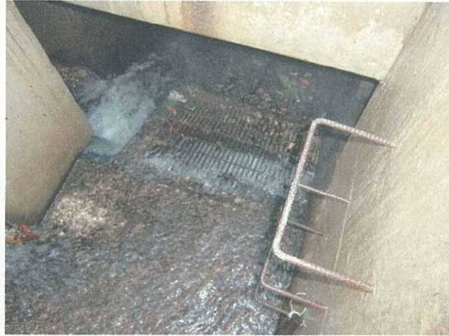
取水口 ごみ掃除後
