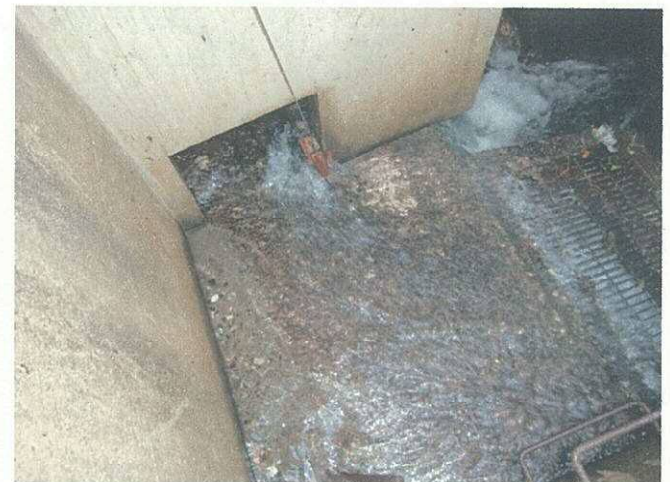
取水口 取り込み側
