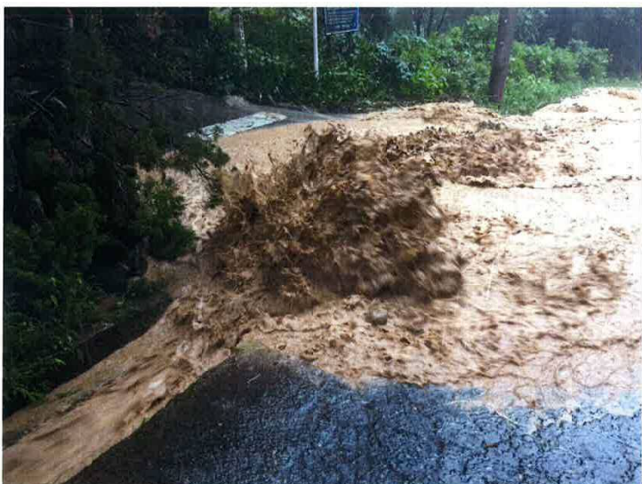
市道側溝林道側 溝合流部
