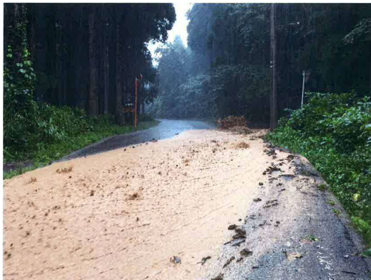
市道側溝林道側 溝合流部
