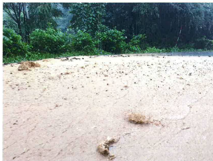
市道坂下閑乗寺線 溢水・土砂
