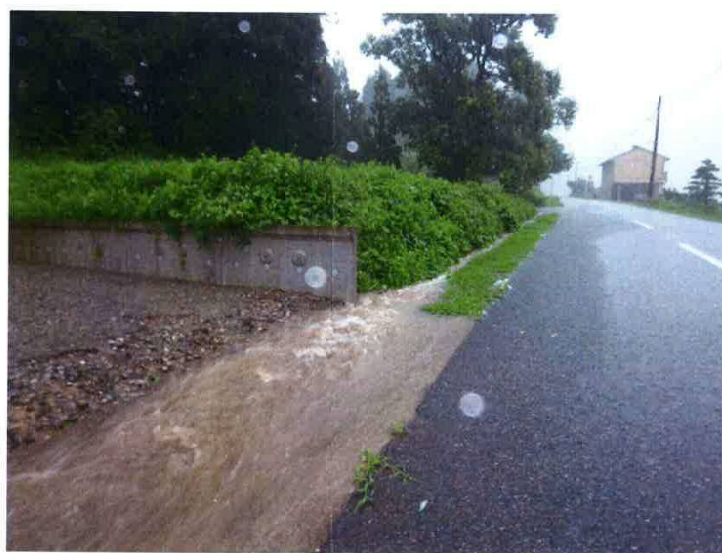
市道山見戸板線 中間地点より
