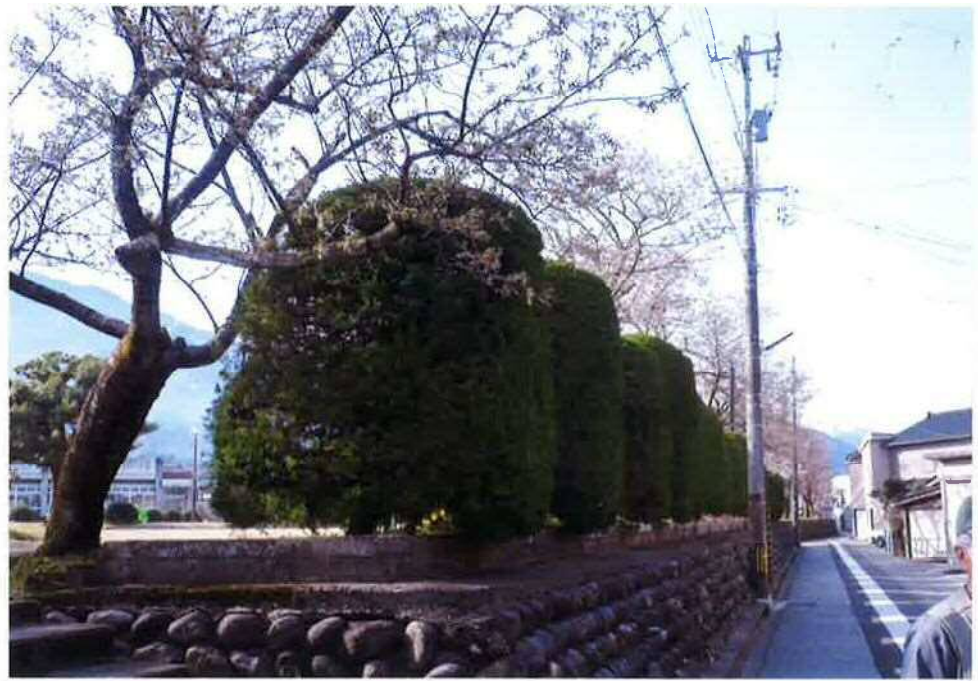
桜の枝、電線の接近状況(北より南) ①
