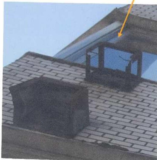
看板の取り付け金具の劣化 (エ方面の壁)
