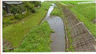
VI-2(2)干谷川浚渫 (院瀬見地内)
