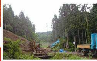
VI-3 川原毛谷 (流路・谷止工)
