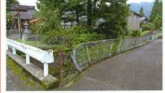
VI-2(4)中江川 (転落防止柵補修)
