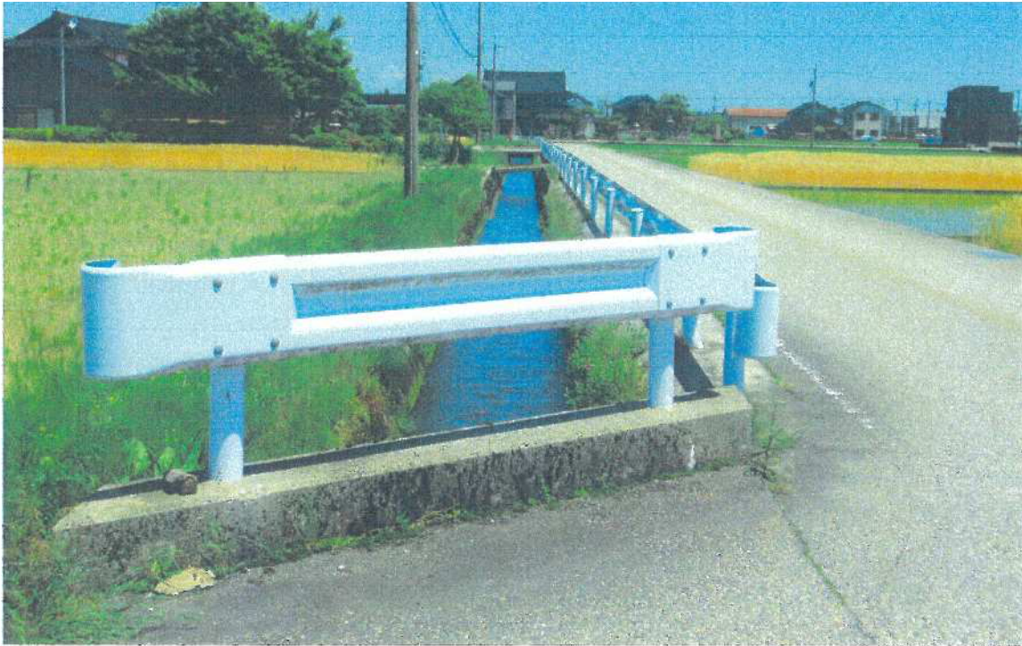
現地より遊部方面視 舗装道路として整備有 転落防止柵有
