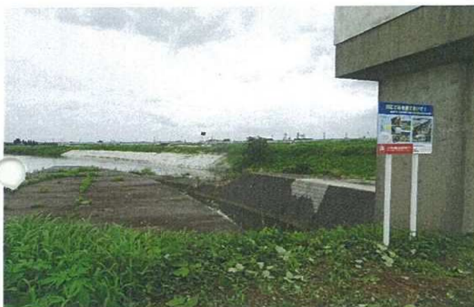
本江地内・5 小矢部川、旅川合流点への清水川排水ゲート
