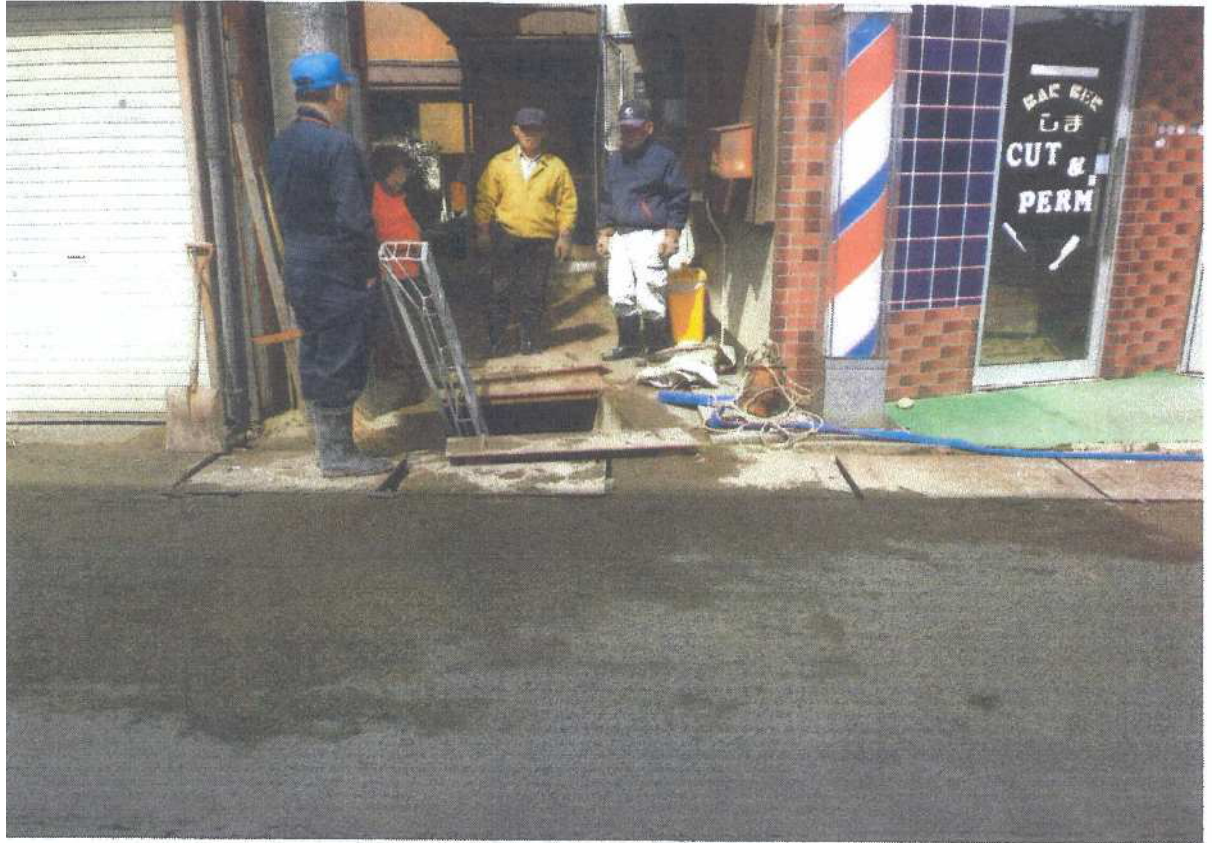
嶋理容院横 下流出口
