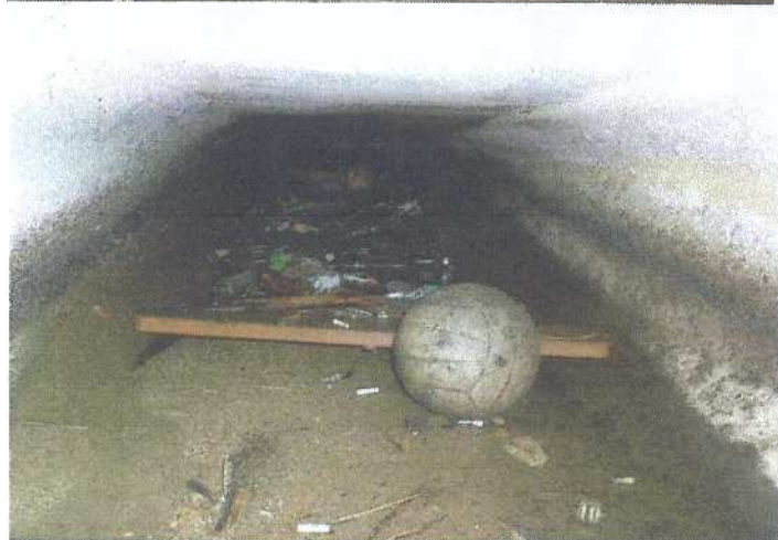
上流側よりの内部
