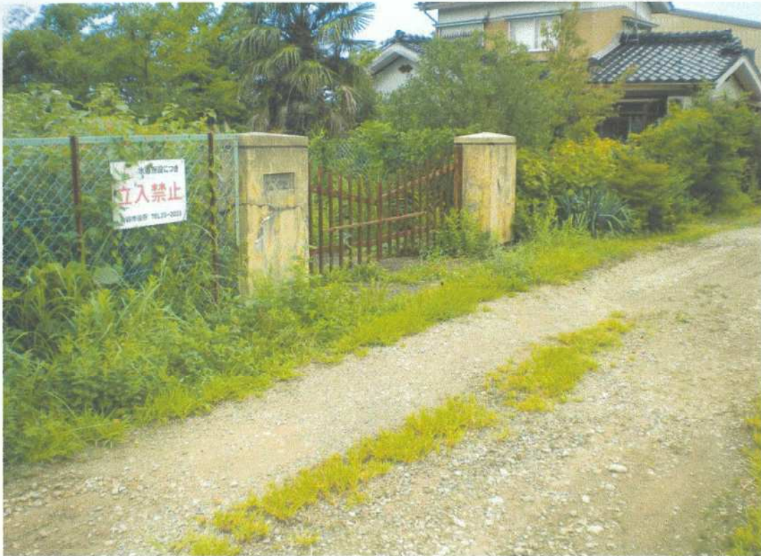
要望化箇所道路に面した水道施設入口 ①
