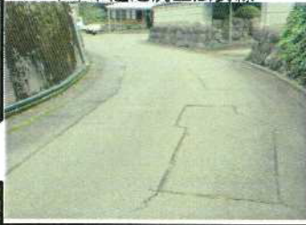
1ー(1)市道池尻上広安線
