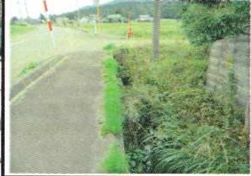
1ー(3)市道高屋井口線 池田地
