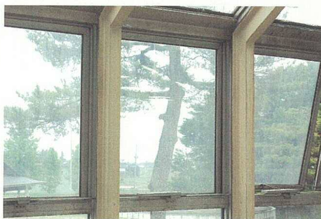
ワイヤーがささくれ、完全には閉まらない窓（4年フロア横廊下）
