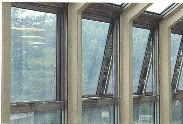
ワイヤーがささくれ、完全には閉まらない窓（4年フロア横廊下）
