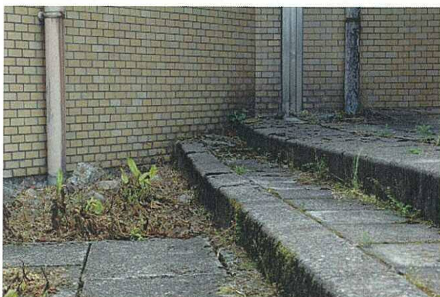
不等沈下により、波打つ犬走り
