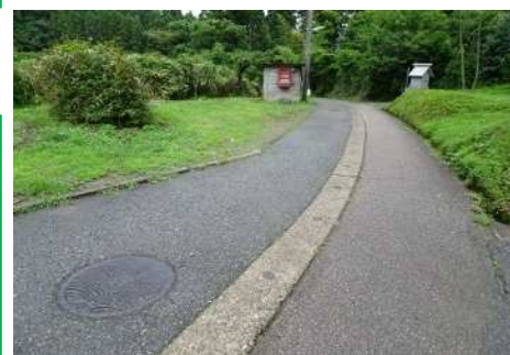
1 志観寺町内防火水槽の設置
