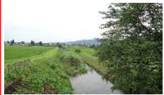
VII-2(1)干谷川浚渫 (沖地内)
