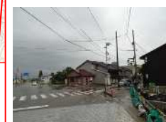
IV-1 八日町通り・本町通り 道路横断電線等地下埋設
