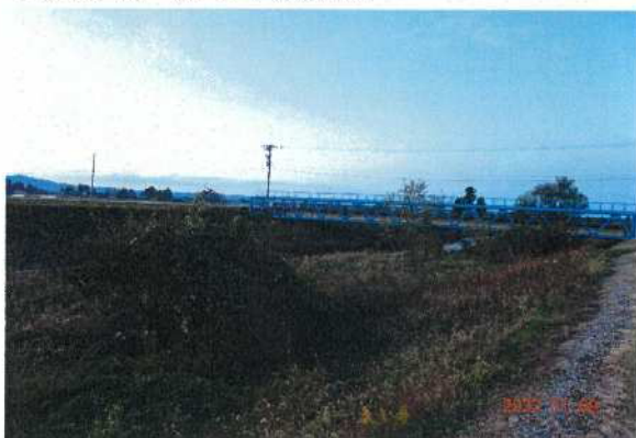
上流側から 北井橋
