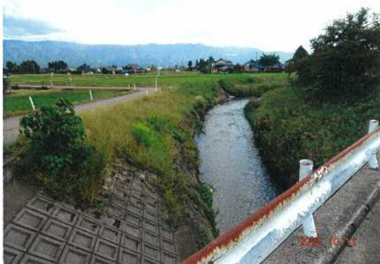
大井川 福中製作所付近から上流方向
