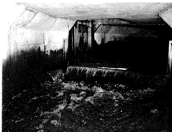
左写真暗渠内(6月から水位が下がるためもう一枚堰板追加)
