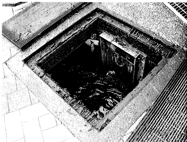
前頁下写真より10m余り下流の取水口
