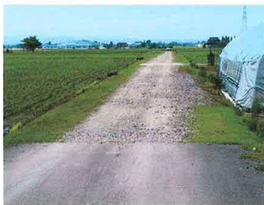
C点より北方向を見る。
