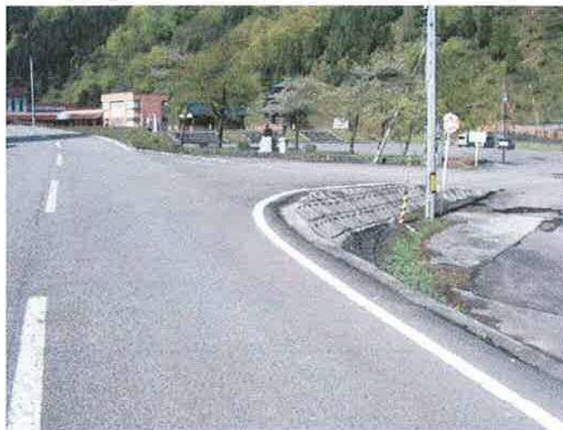
1-②下田線と新田下田線(一部重複路線)の分岐箇所 下田線起点側から終点方向
