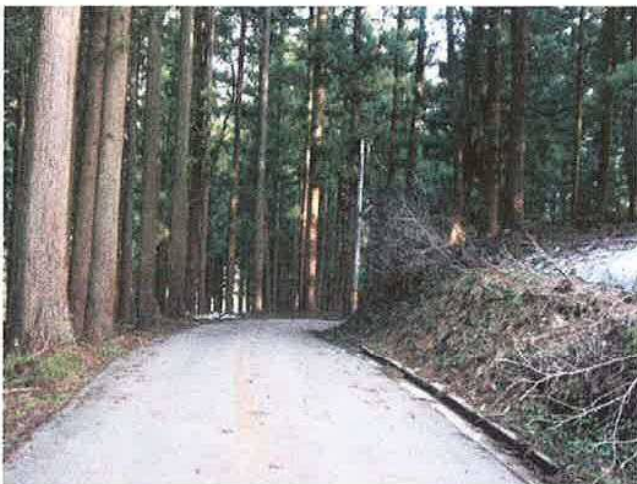
1-① 藤巻線 終点側⇒起点側8 拡幅改良要望
