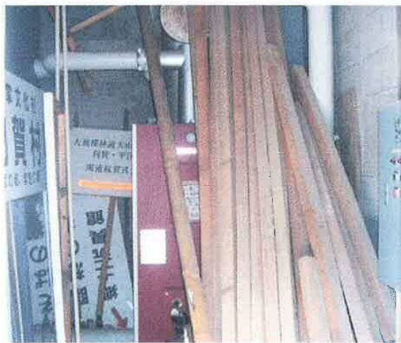
2-② ボイラー設備棟内部
