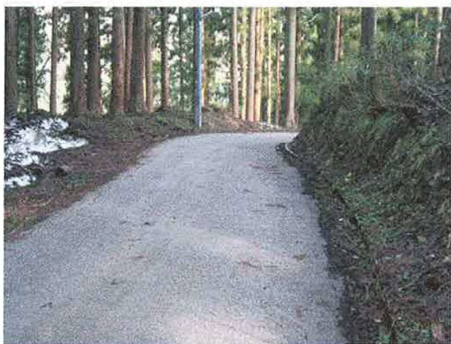
1-① 藤巻線 終点側⇒起点側6 拡幅改良要望
