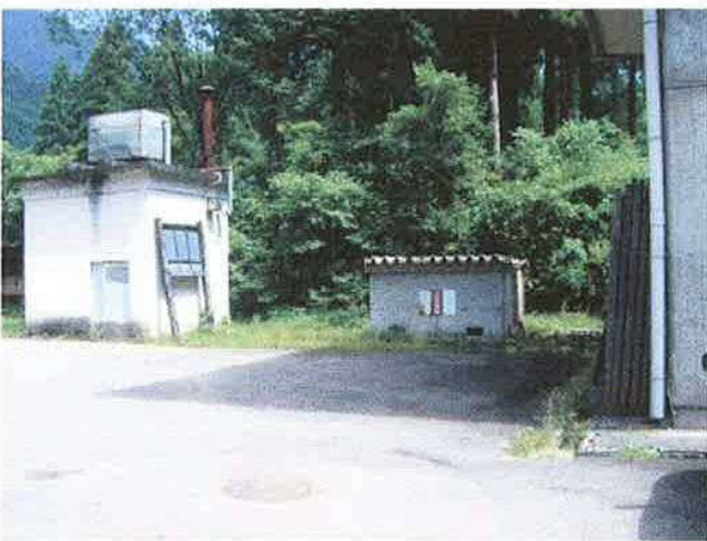
2-② 坂上公民館 ボイラー施設棟(左)・ガスボンベ棟(右)
