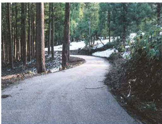
1-① 藤巻線 終点側⇒起点側7 拡幅改良要望
