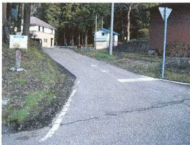
1-①藤巻線 終点側⇒起点側1(坂上上百瀬線 取付) 勾配修正要望
