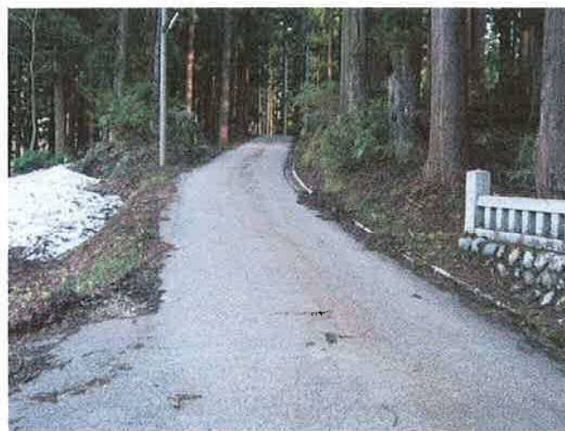
1-①藤巻線 終点側⇒起点側5 拡幅改良要望
