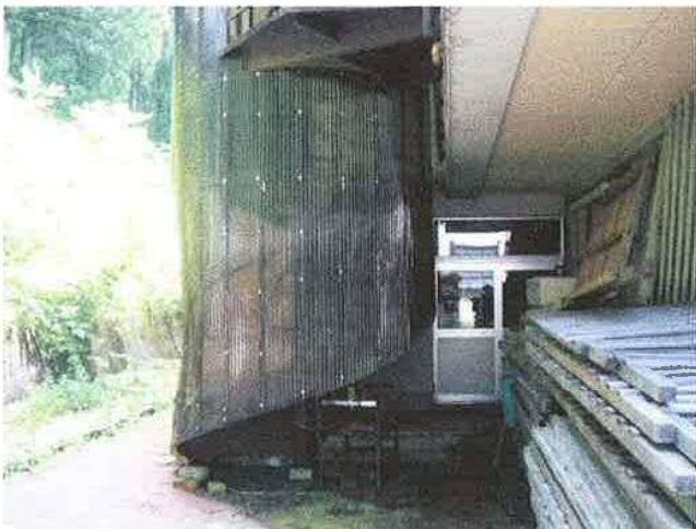
2-①坂上公民館 非常階段 下部
