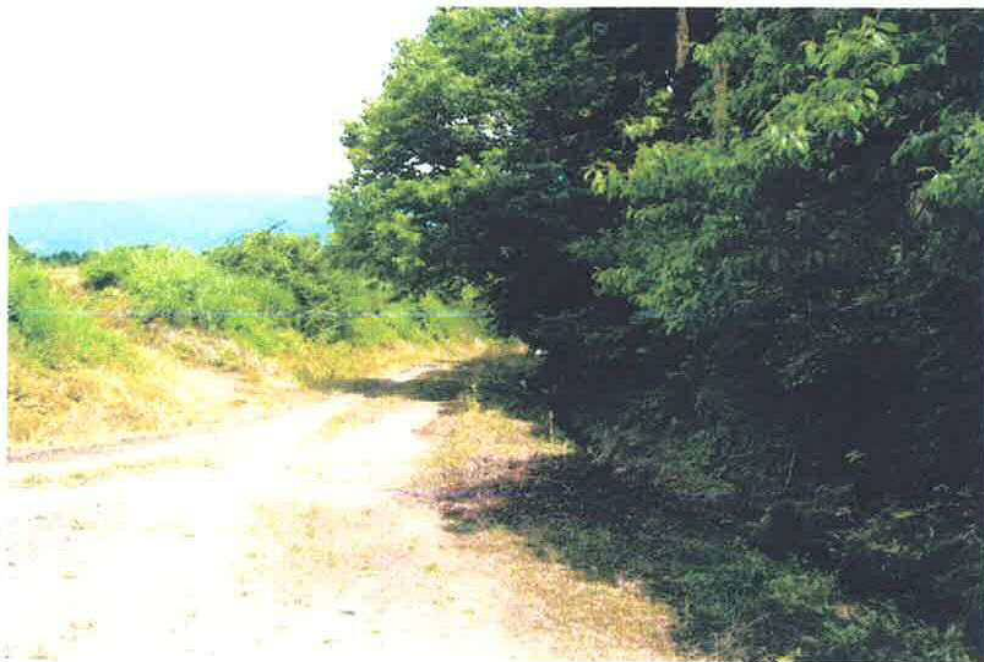
道路上に雑木が出ている状態
