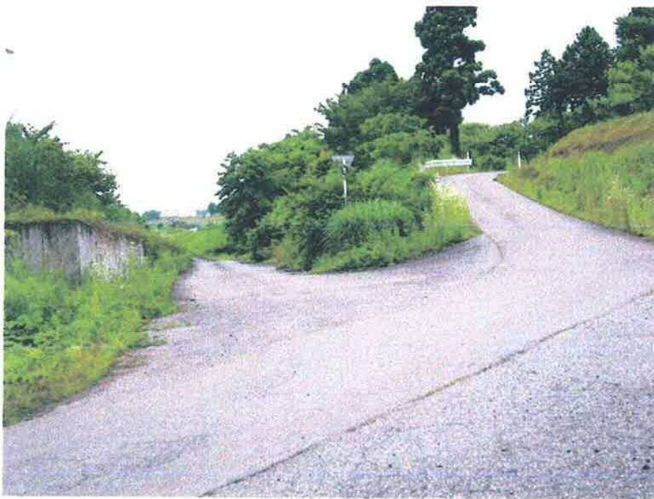
高速道路側から
