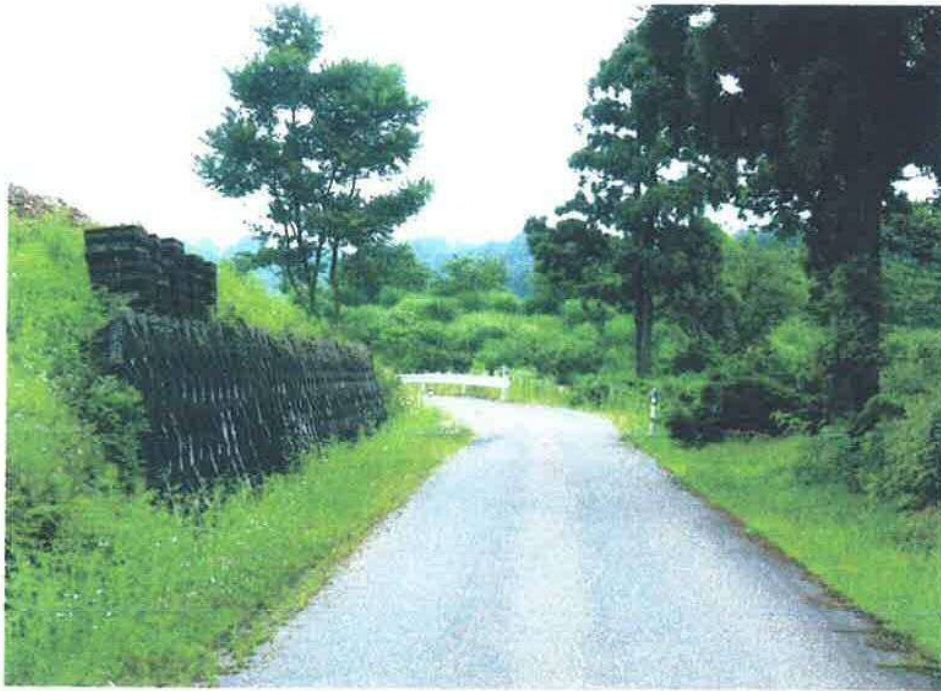
県道才川七線京塚地内より
