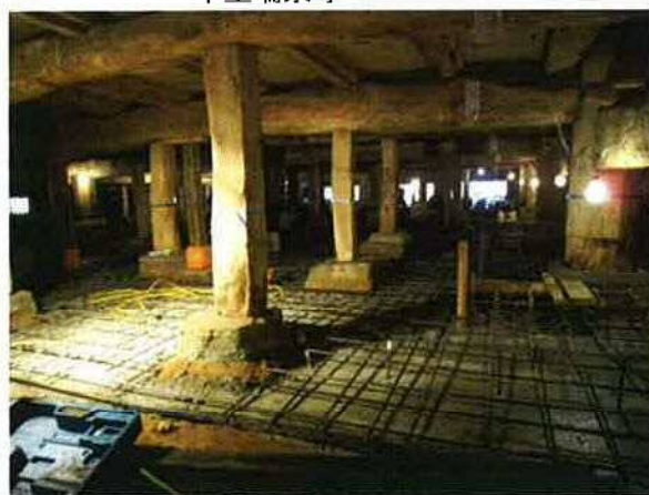
本堂耐圧盤設置
