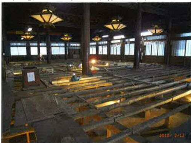
本堂床下工事
