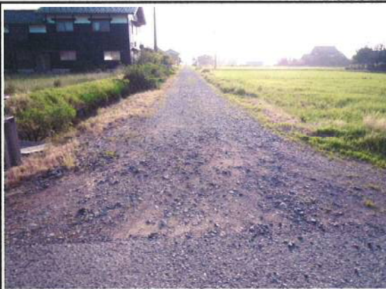
7月5日撮影: 東側接続箇所
