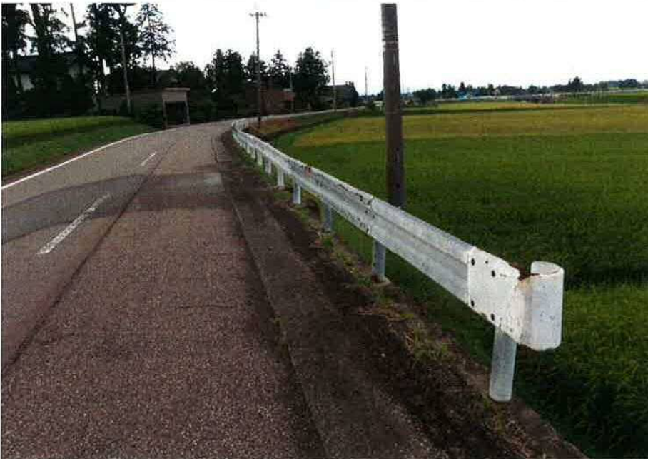
専勝寺院瀬見線 沖地内ガードレール
