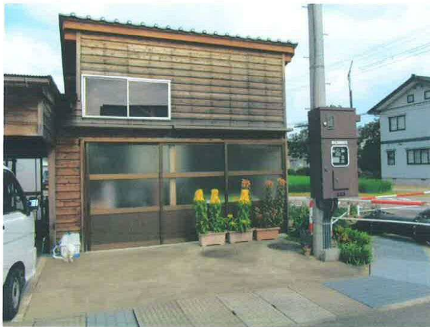
揚水ポンプ(別図 B 地点)写真
