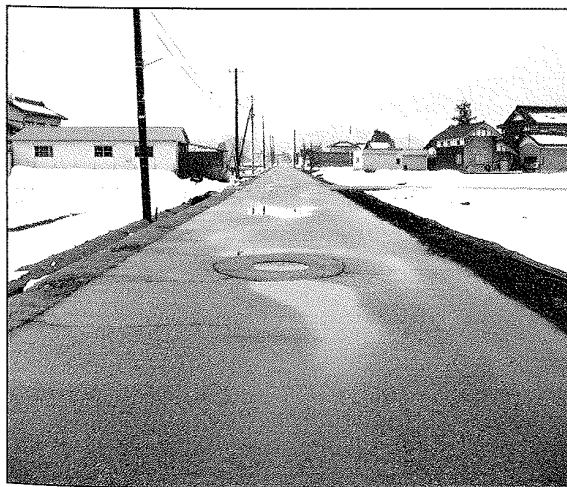
市道下吉江三ツ屋 1 号線の道路の凹凸と亀裂
