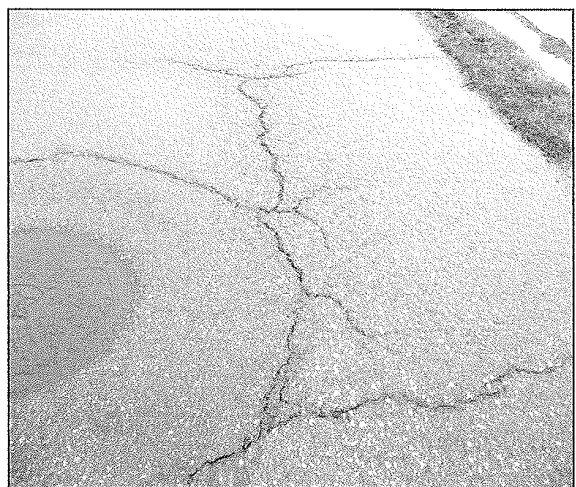
市道下吉江三ツ屋 1 号線の道路の凹凸と亀裂
