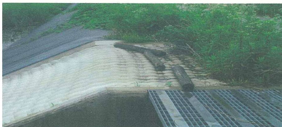
安全柵が腐敗しすべて倒れて機能を果たしていない状態
