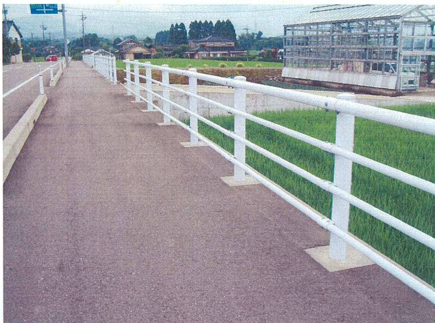
③歩道墜落防止設備(設置済)
