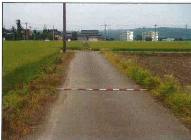
位置: 要望道路 西側端部 舗装幅 3m
