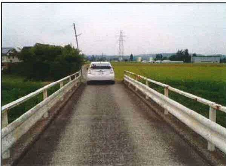
位置: 日吉橋(右岸から左岸方向)
