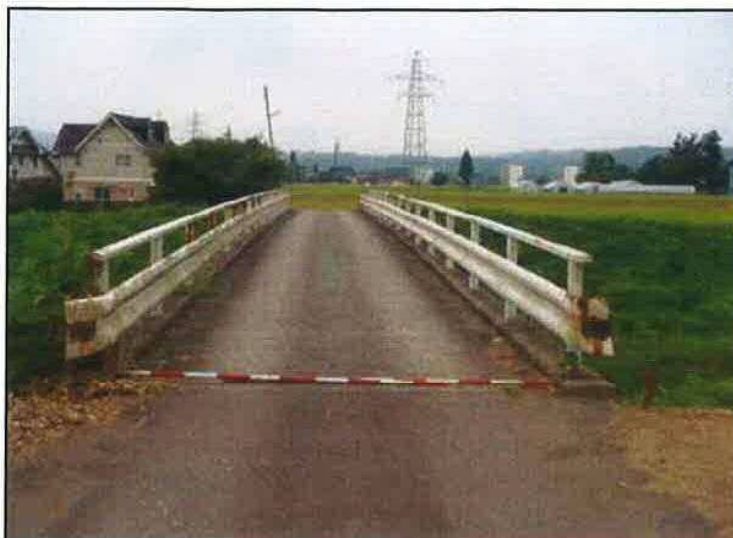
位置: 橋梁有効幅員 2.7m
