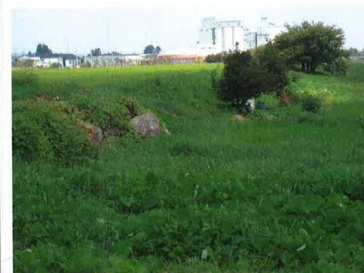
未整備堤防箇所
