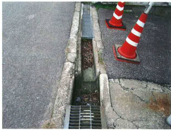
側溝修繕箇所(市道山見15号線交差:下流)
