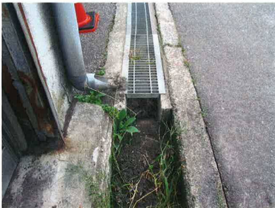
側溝修繕箇所(市道山見15号線交差:上流)
