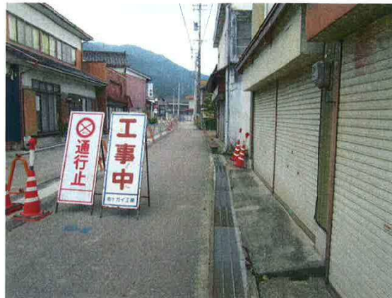
側溝修繕箇所(下流側より)
