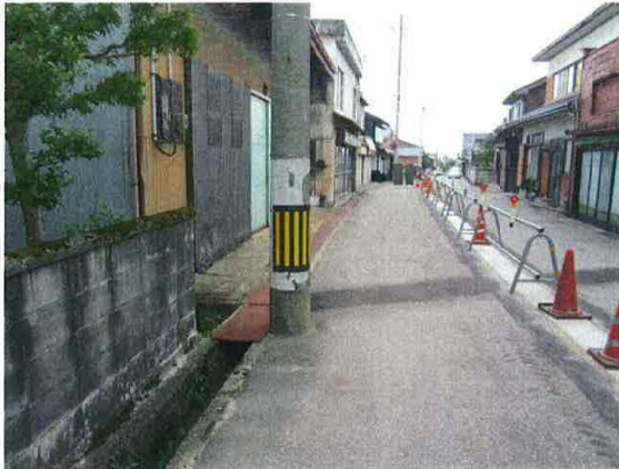
側溝修繕箇所(上流側より)
