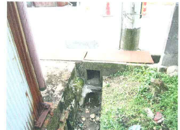
側溝修繕箇所(土改用排水路交差箇所)
