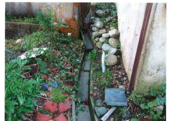
側溝修繕箇所 (土改用排水路:下流水路荒廃)
