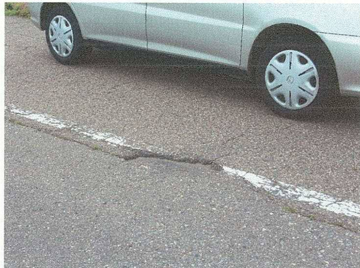
②コンクリート剥がれ
