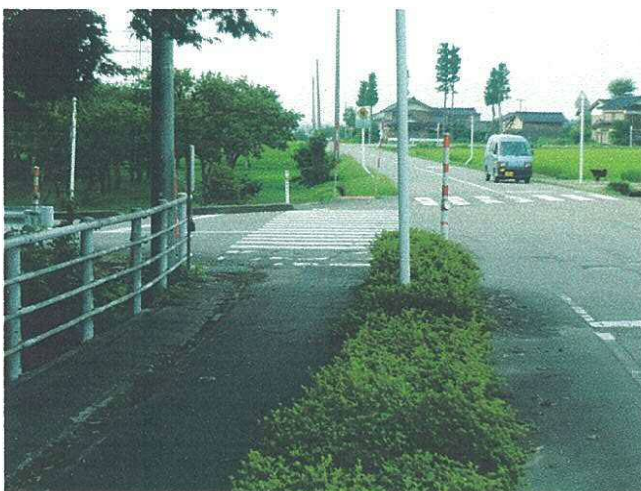
西島地内から北島地内方向 (既設歩道が止まっている)
