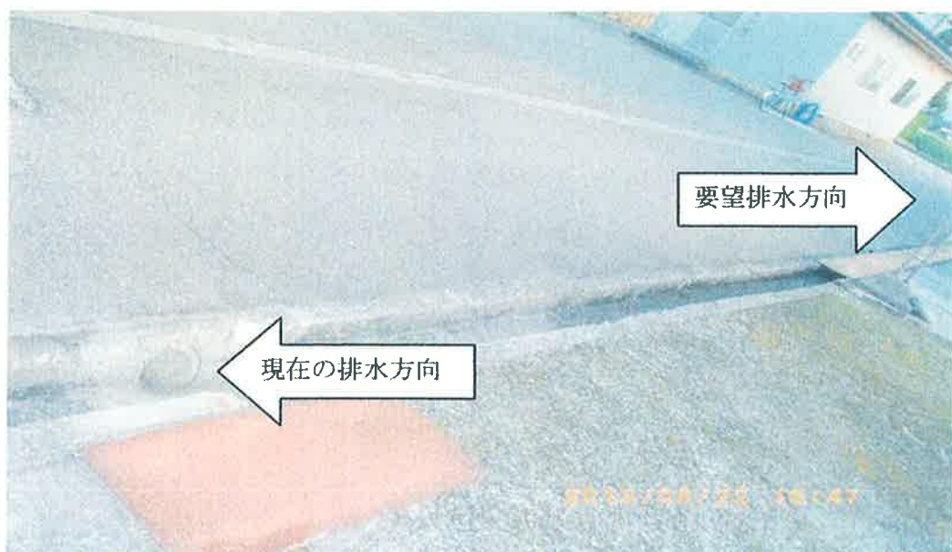
排水口の状況
