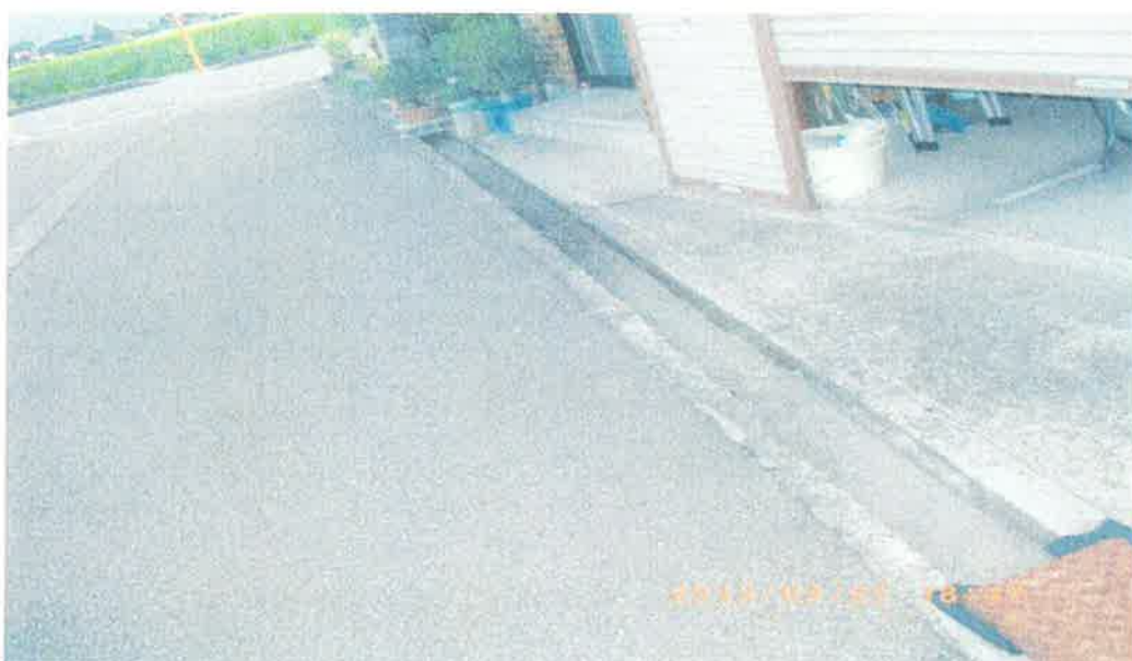
排水路の状況
