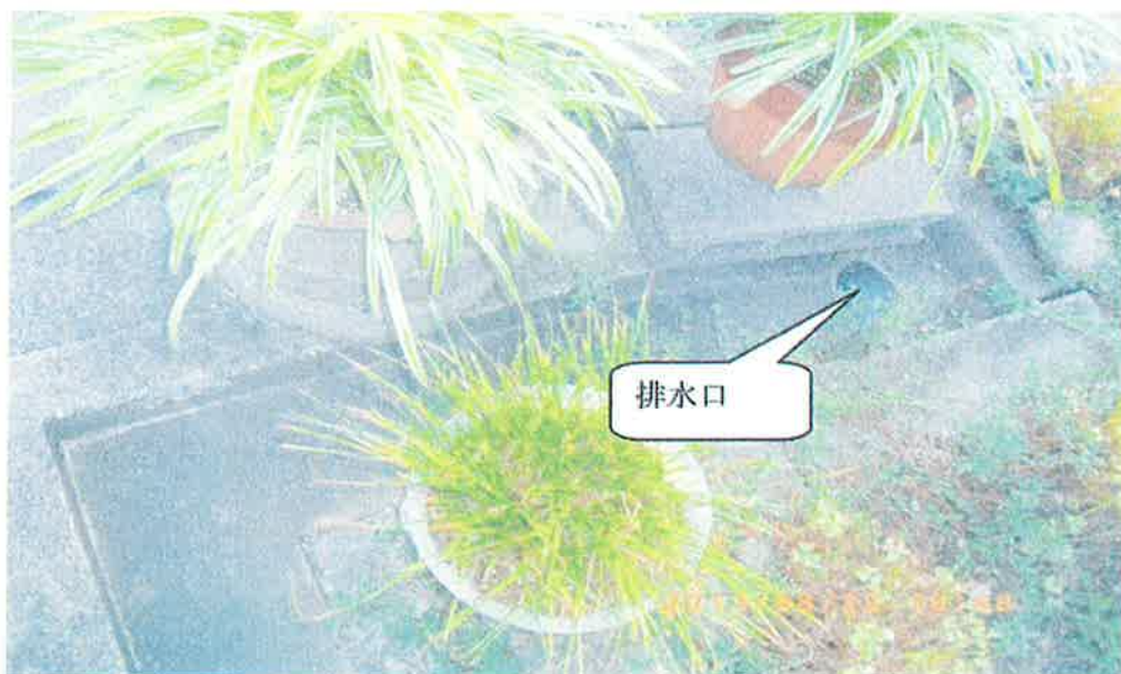
道路側排水口
